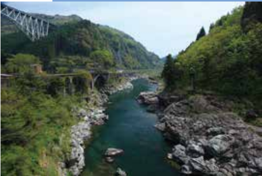
高千穂鉄道跡のアーチ橋下に見られる枕状溶岩の溪谷
