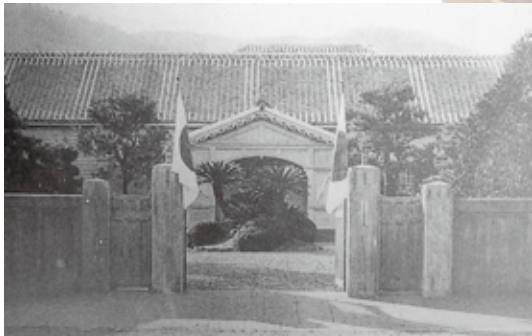
旧延中の正門
